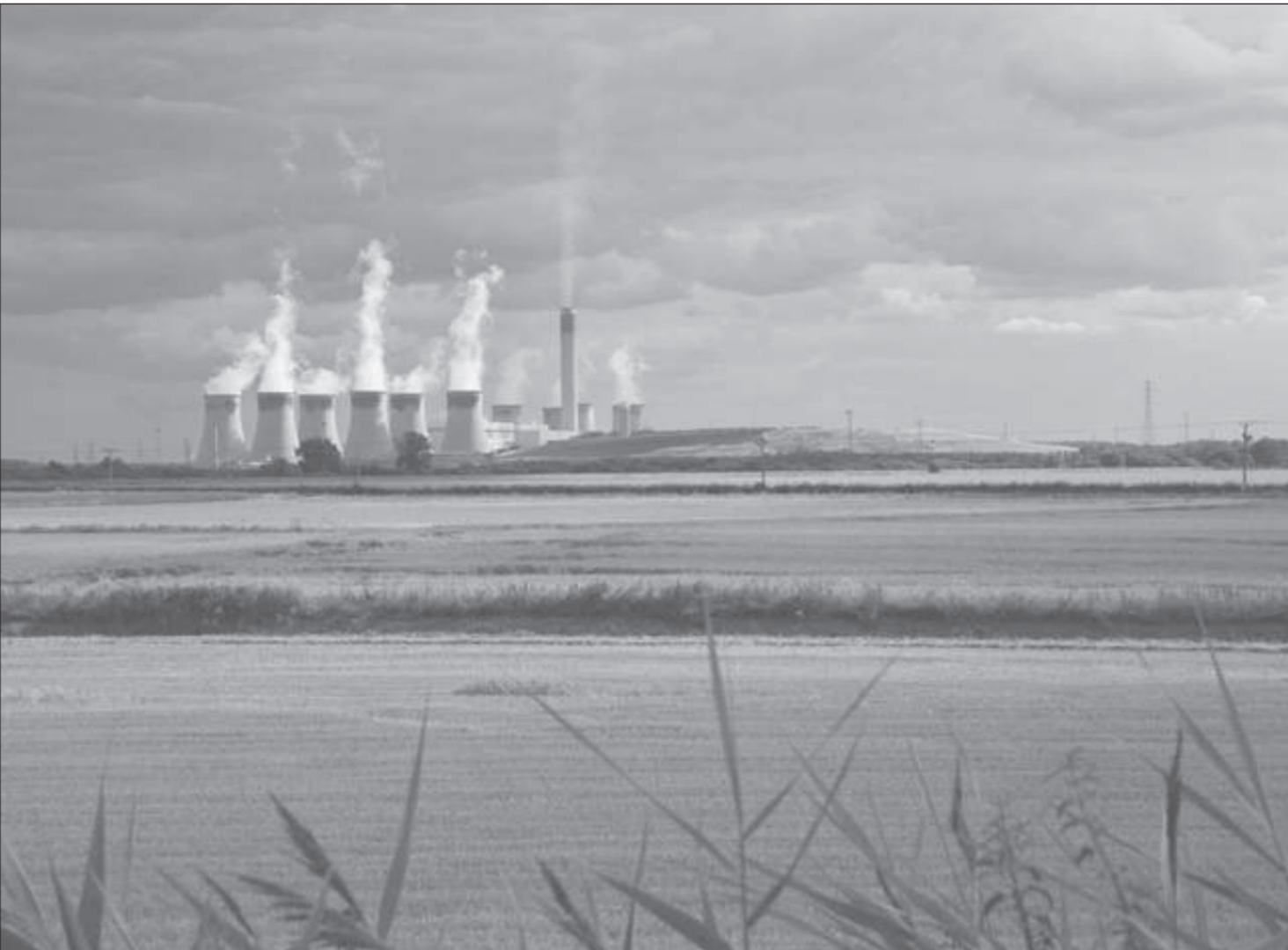
สถานีไฟฟ้าแรงดันในเยอรมนีใช้พลังงานถ่านหินและชีวมวล (ภาพจาก eandt.theiet.org)
