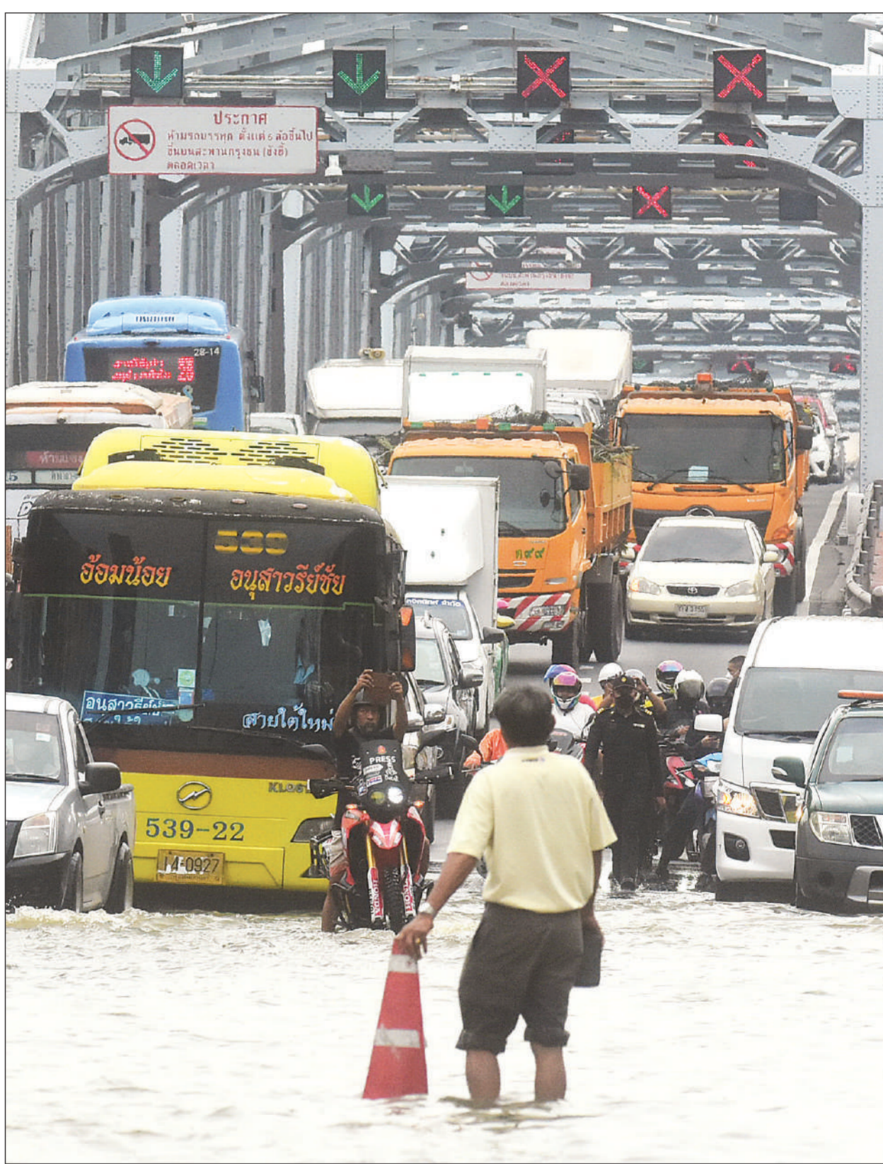
เมื่อช่วงเช้าวันที่ 8 พ.ย. ระดับน้ำเจ้าพระยาหนุนสูง จนทำให้เขื่อนกันน้ำได้สะพานกรุงธน (ชิงอี) พังทลาย ส่งผลให้น้ำทะลักท่วมถนนสะพานกรุงธนสูงถึง 30 ซม. การจราจรติดขัดอย่างหนัก ขณะที่ชุมชนใกล้เคียงต้องขนของขึ้นที่สูง
