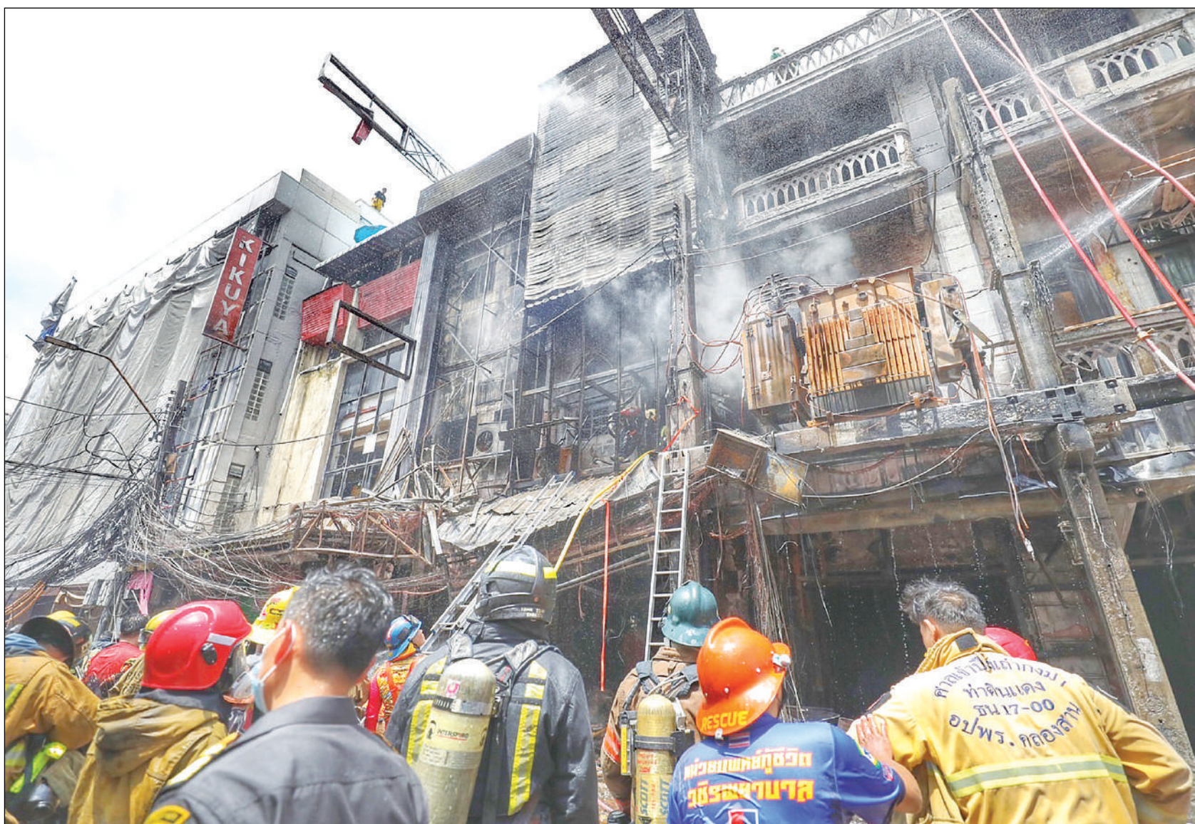
สภาพความเสียหายของอาคารพาณิชย์ย่านตลาดสำเพ็ง หลังเกิดเหตุหม้อแปลงไฟฟ้าระเบิด เปลวเพลิงลุกลามเข้าไปภายในตัวอาคาร จนทำให้มีผู้เสียชีวิต 3 ศพ และบาดเจ็บ 9 ราย เมื่อวันอาทิตย์ที่ 26 มิถุนายน 2565
