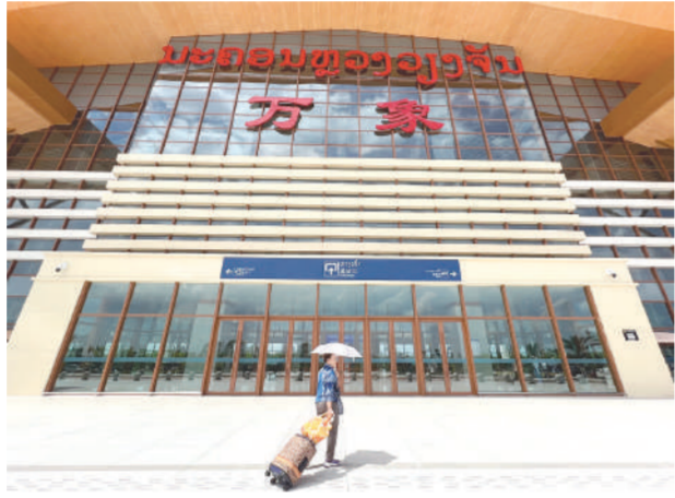
ทางเข้าด้านในอาคารสถานีเวียงจันทน์
