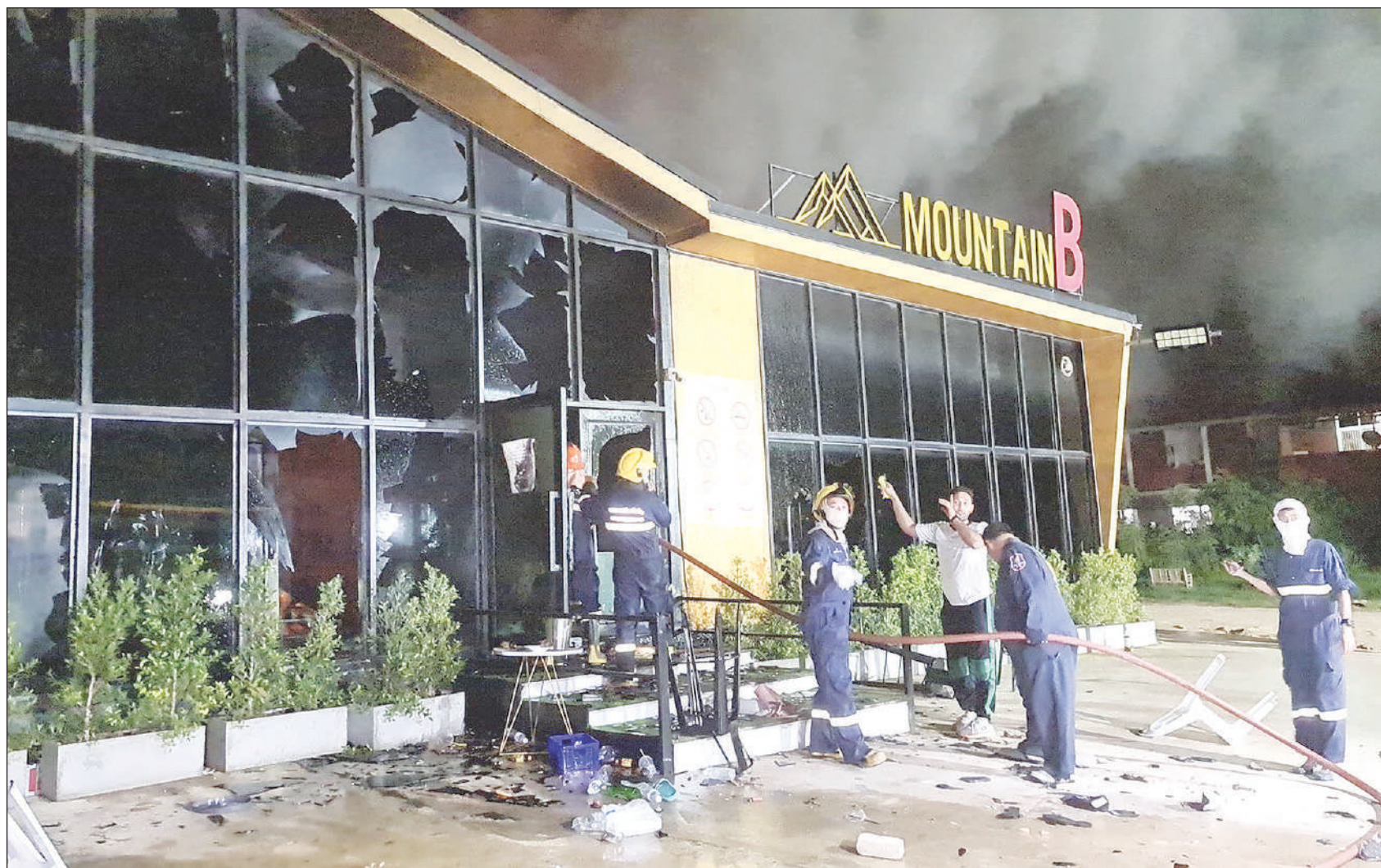
เจ้าหน้าที่กำลังช่วยกันดับเพลิงดับ MOUNTAIN B ที่ตั้งอยู่ปากซอยลัดทึบสุขุมวิท 99 (เขามอน) ต.พุดตาลหลวง อ.ลัดทึบ จ.ชลบุรี เหตุเกิดเมื่อช่วงประมาณตีหนึ่งวันที่ 5 สิงหาคม 2565 ซึ่งมีผู้เสียชีวิต 14 ราย และบาดเจ็บนับสิบราย
